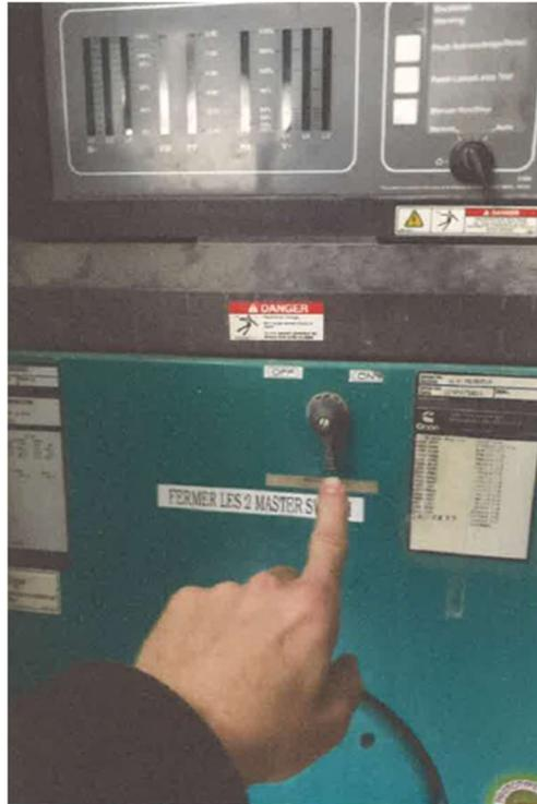
Pour finir, il faut aller remettre l'électricité d'hydro Québec dans le campement donc, il faut pousser rapidement vers le haut la poignée de l'interrupteur en utilisant le bras gauche (pour ne pas être devant l'interrupteur). Après cette manœuvre, le courant devrait être remis sur le camp.
